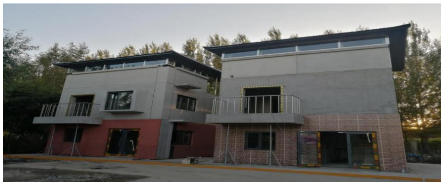
案例 18-图 3：装配式建筑工法楼
